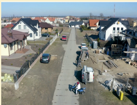
Ulica Raclawicka przed modernizacją
