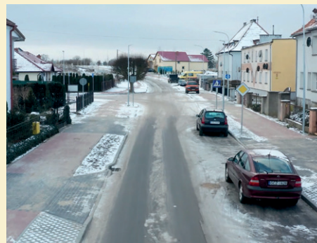
Ulica Kościuszki po modernizacji
