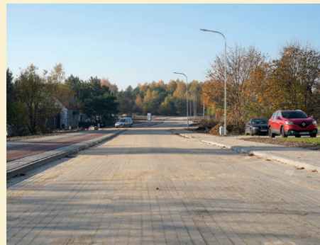
Aleja Lawendowa po modernizacji
