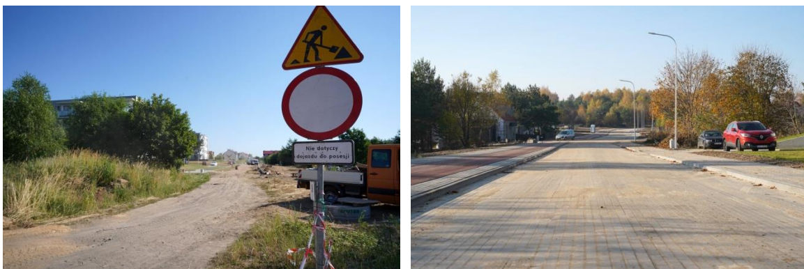
Fot. 4. Aleja Lawendowa – przed i po wykonaniu prac.
