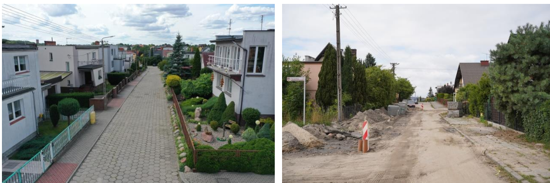
Fot. 7. Ulica Bema przed i podczas przebudowy
