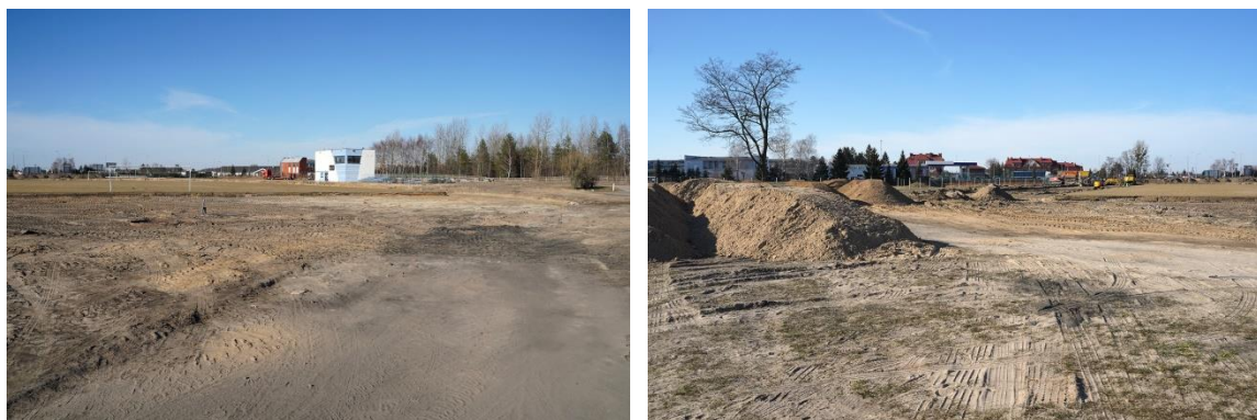
Fot. 10. Prace budowlane na stadionie OSiR.
