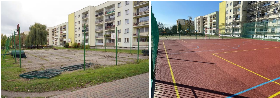
Fot. 2. Boisko na os. Sikorskiego (w trakcie i po wykonaniu inwestycji).
