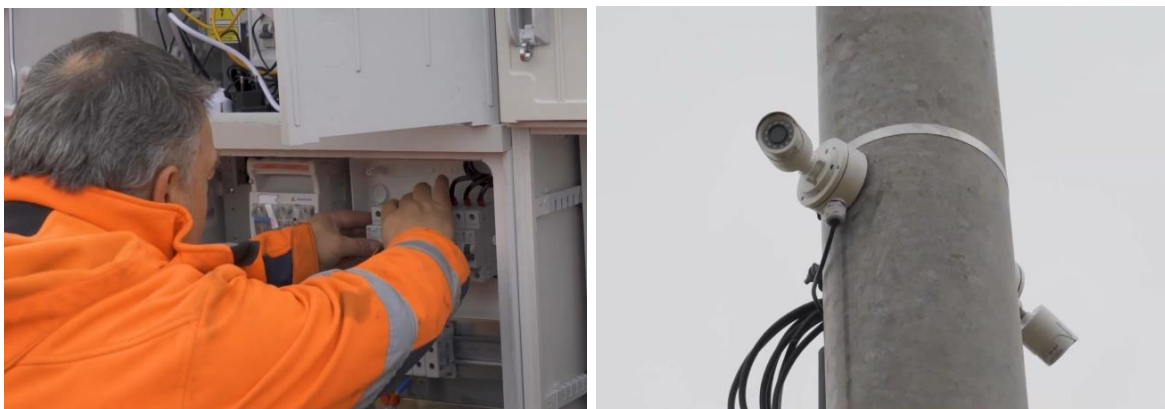
Fot. 1. Zadanie „Elektryfikacja i monitoring części działki nr 1098 jako zaplecza terenów sportowo – rekreacyjnych – ul. Kamienna” po realizacji.
