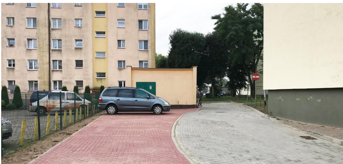
Fot. 4. Droga dojazdowa do bloku przy ul. Traugutta 7a po remoncie.
