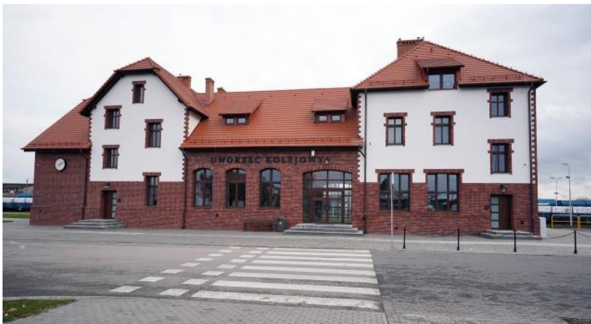
Fot. 9. Budynek dworca kolejowego po przebudowie.
