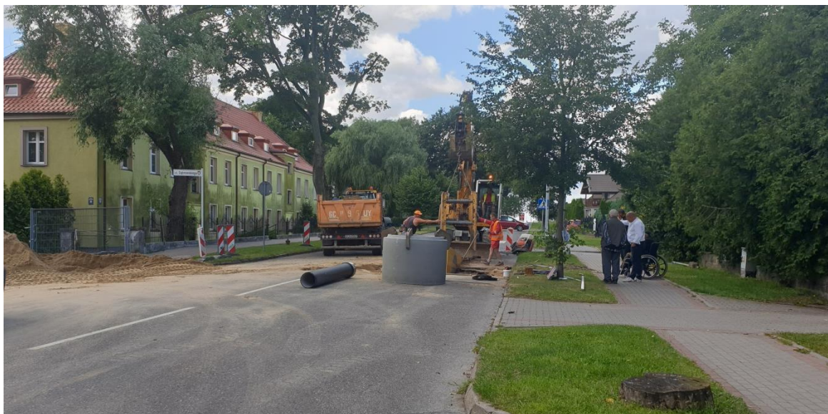
Fot. 12. Prace budowlane na ul. Dąbrowskiego w lipcu 2020 r.
