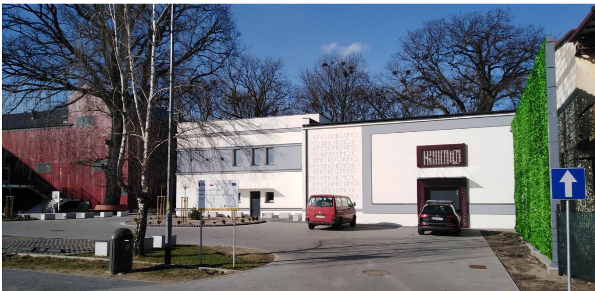
Fot. 15. Budynek kina po termomodernizacji od strony wyjścia.
