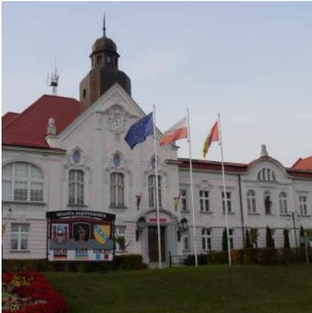
budynek Urzędu Gminy - dawna preparanda
