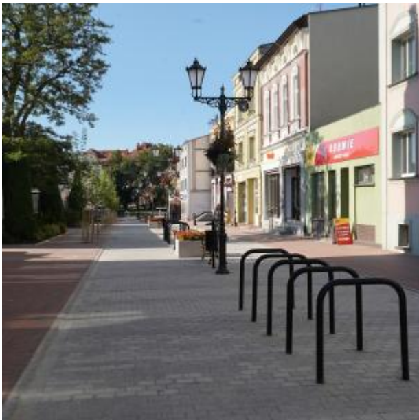
Królewska po remoncie 2025
