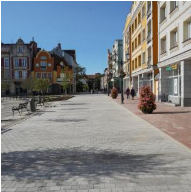
Królewska po remoncie 2025
