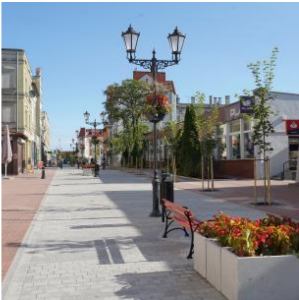
Królewska po remoncie 2025
