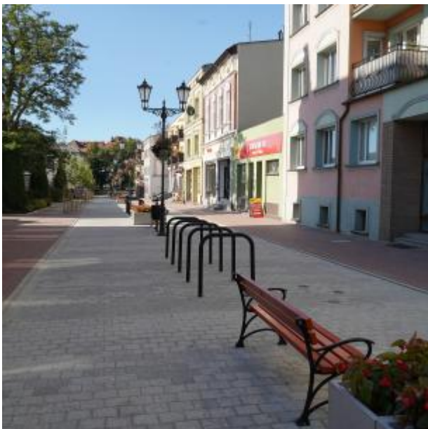
Królewska po remoncie 2025
