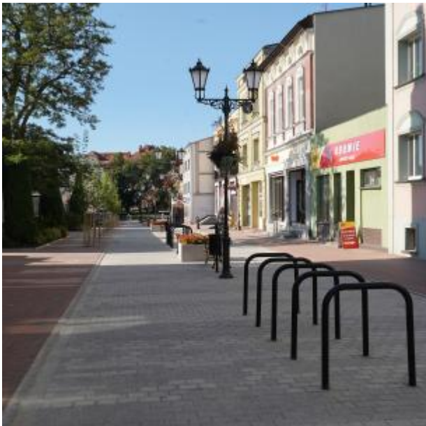
Królewska po remoncie 2025
