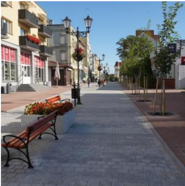
Królewska po remoncie 2025
