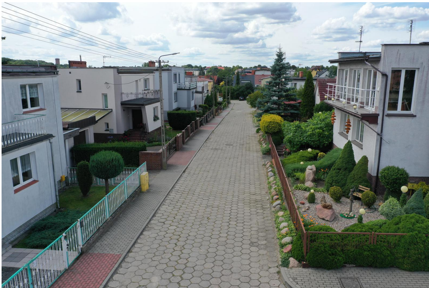
ul. Bema przed rozpoczęciem prac
