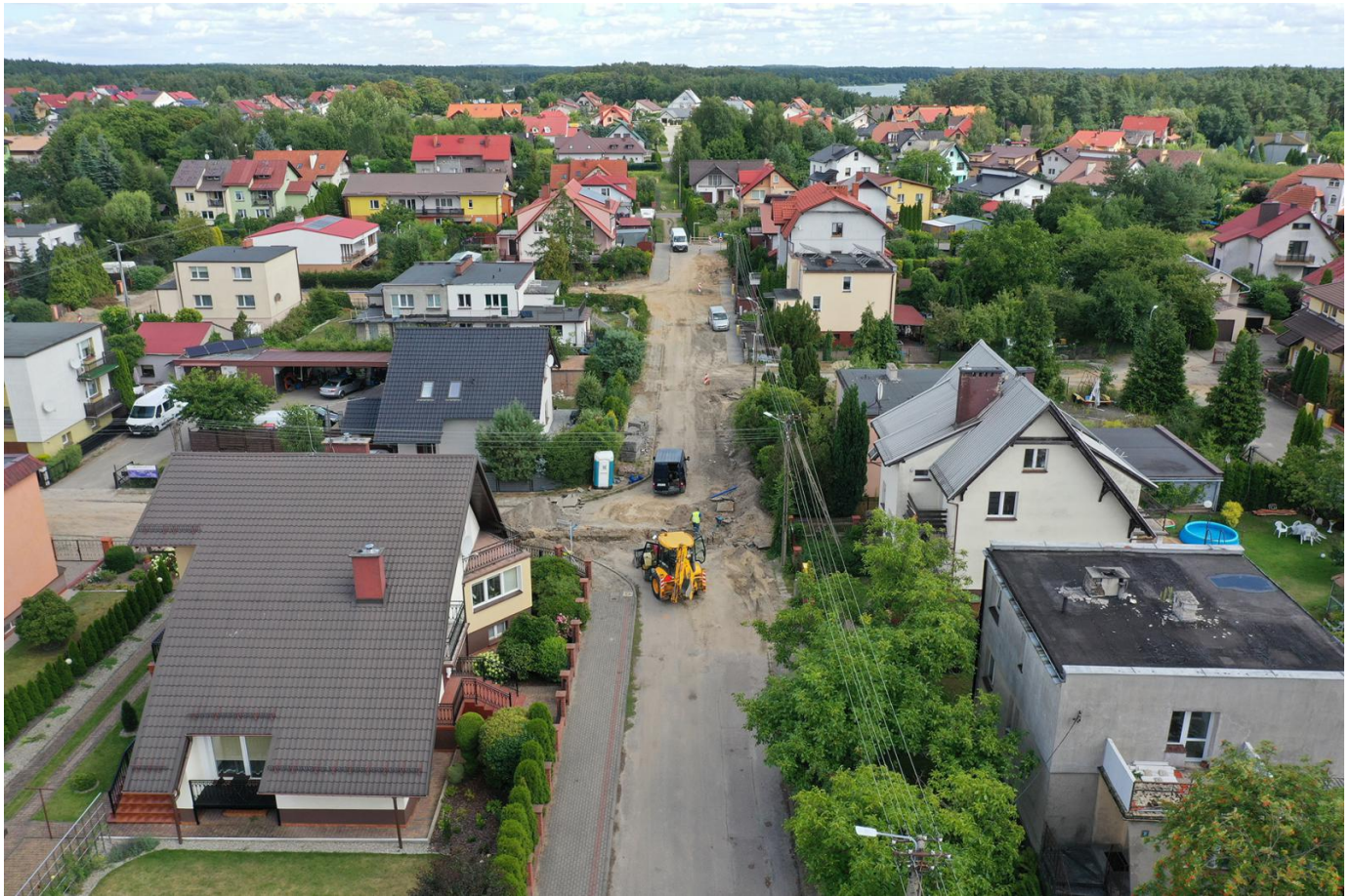
ul. Bema w czasie realizacji prac
