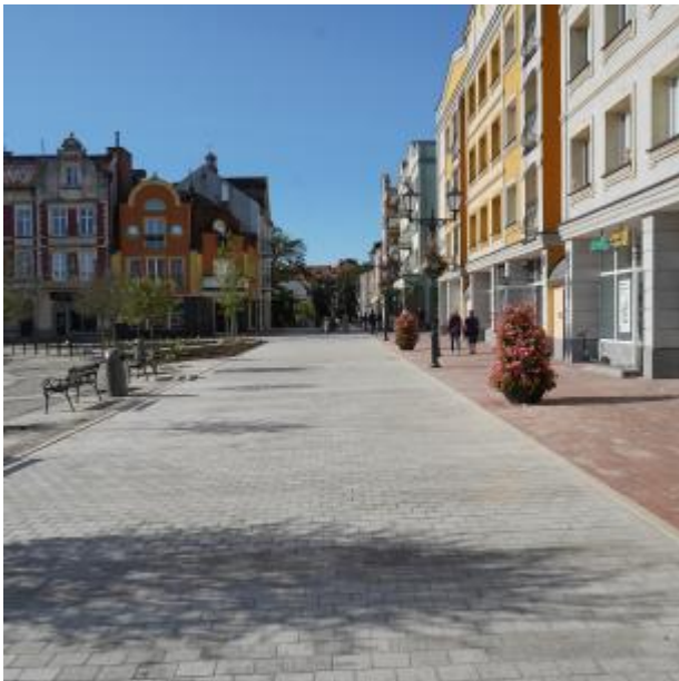
Królewska po remoncie 2025
