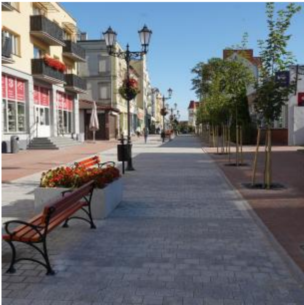
Królewska po remoncie 2025
