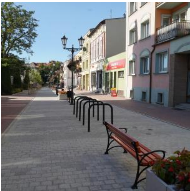
Królewska po remoncie 2025
